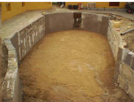
Fundablokke med sandbund. Selvbygger Nordjylland, sommeren 2005. Flot og stemningsfuldt bassin.
