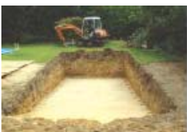
Udgravning og støbning
