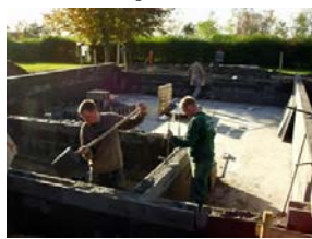
Efterpudsning af vægge
