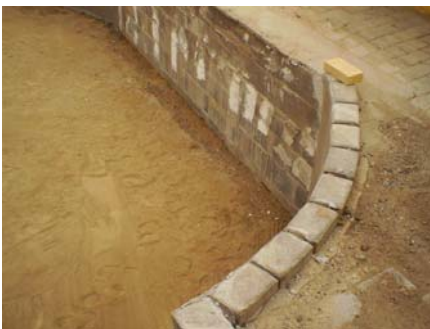
Fundablokke med sandbund. Selvbygger Nordjylland, sommeren 2005. Flot og stemningsfuldt bassin.
